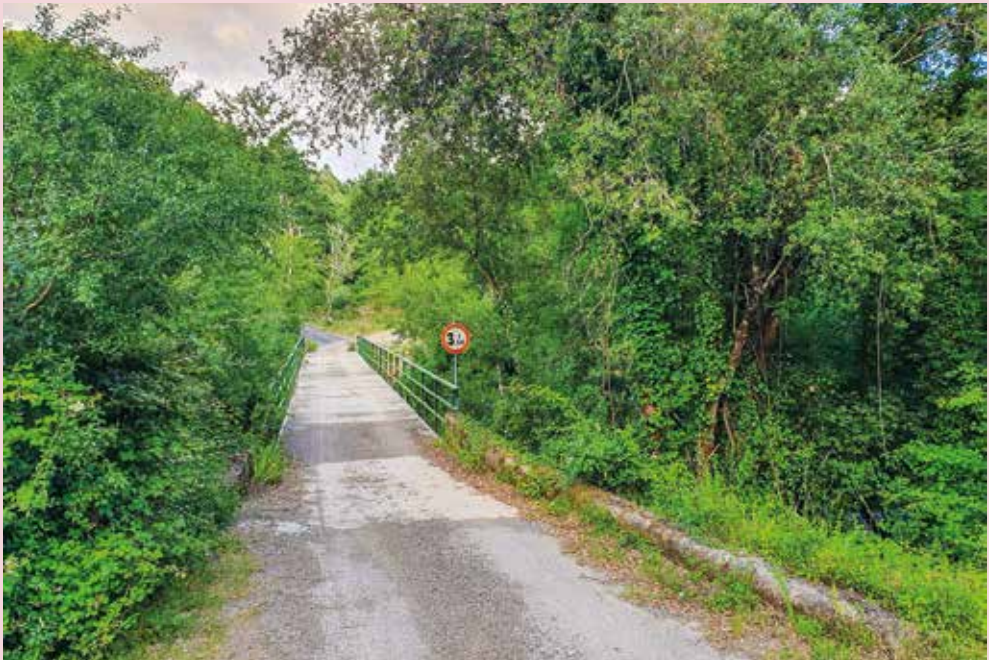
Ponte sul Fiume Mingardo che collega il territorio di Laurito con il comune di Roccafloriosa
