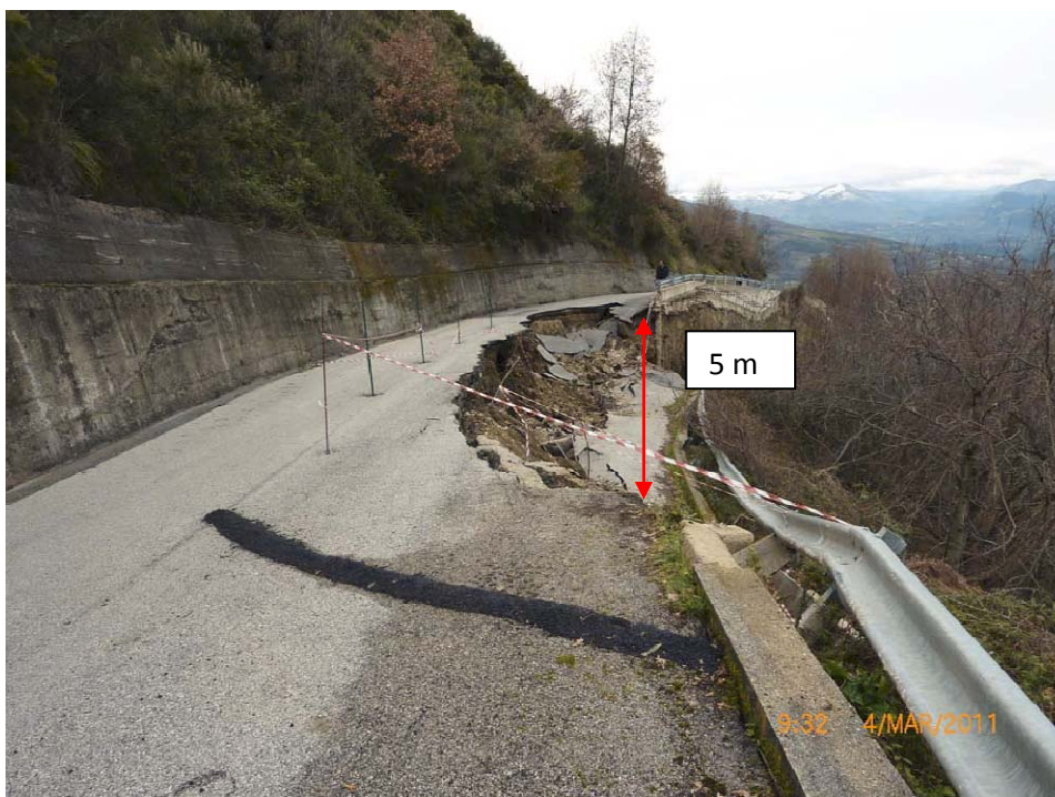
Figura 10: Rigetto della scarpata sommitale dello scorrimento rotazionale.
