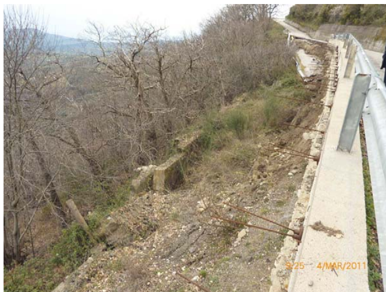
Figura 7: Tratto stradale sistemato
