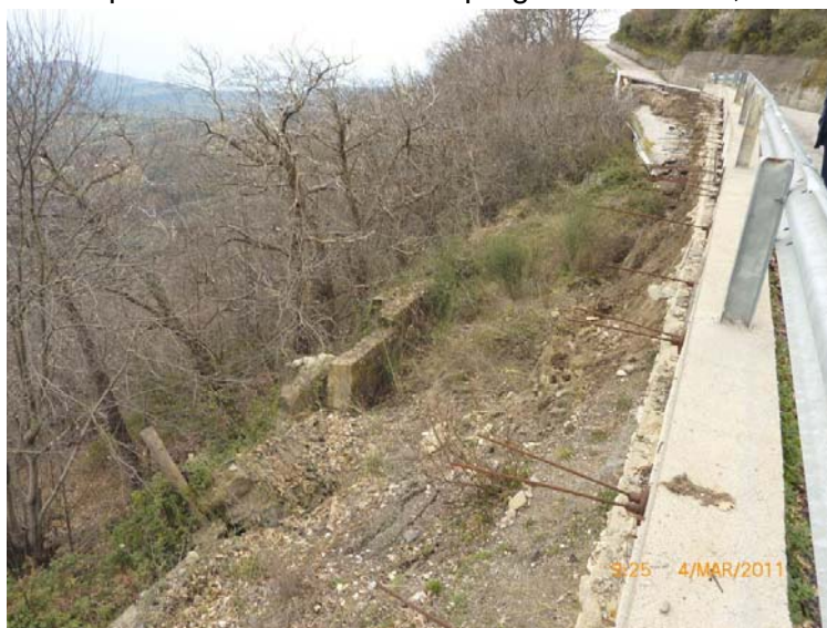
Figura 6: Tratto di strada sistemato con paratia tirantata, rilevato alla data del sopralluogo.
