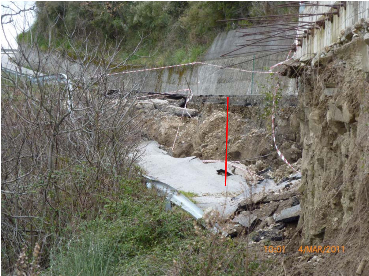
Foto n.10 (altezza in rosso circa 7 mt. dalla sede strad.)
