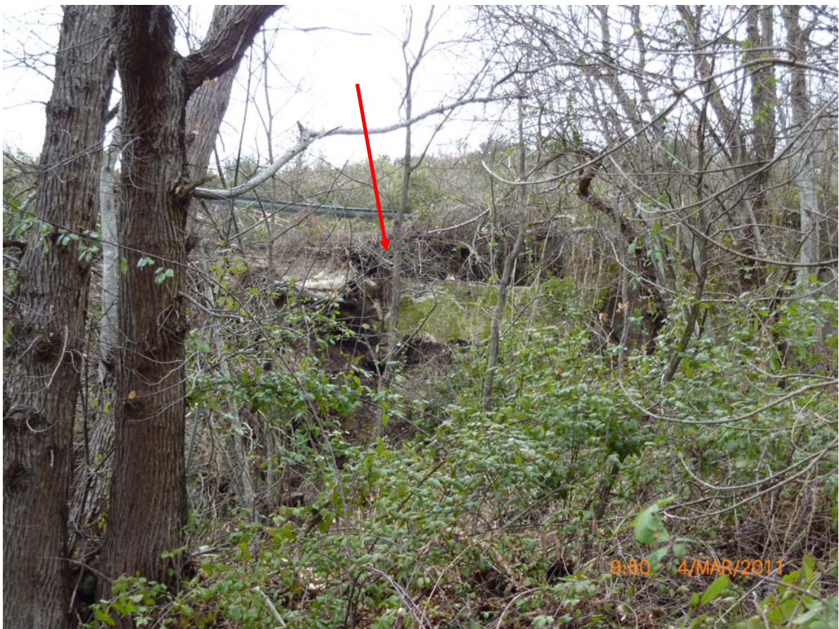
Foto n° .08 (Muri in cls crollati)
